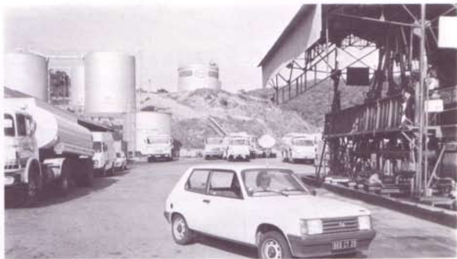
Demain, le dépôt commun de Vazzio, tous produits approvisionnés par un pipe-line de 3 km 700 le reliant au port d'Ajaccio.
